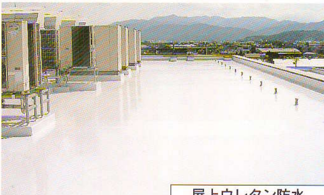
屋上ウレタン防水
